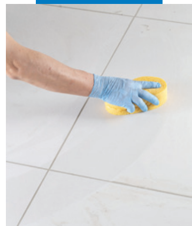
Окончательная очистка плитки с помощью целлюлозной губки
